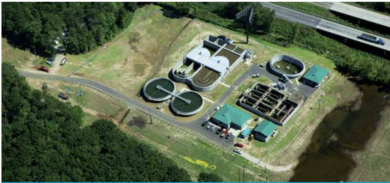
Impianto di trattamento delle acque reflue
