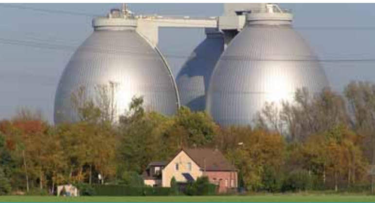
Serbatoi per la digestione anaerobica, impianto di trattamento delle acque reflue «Emschermündung» (Germania)
