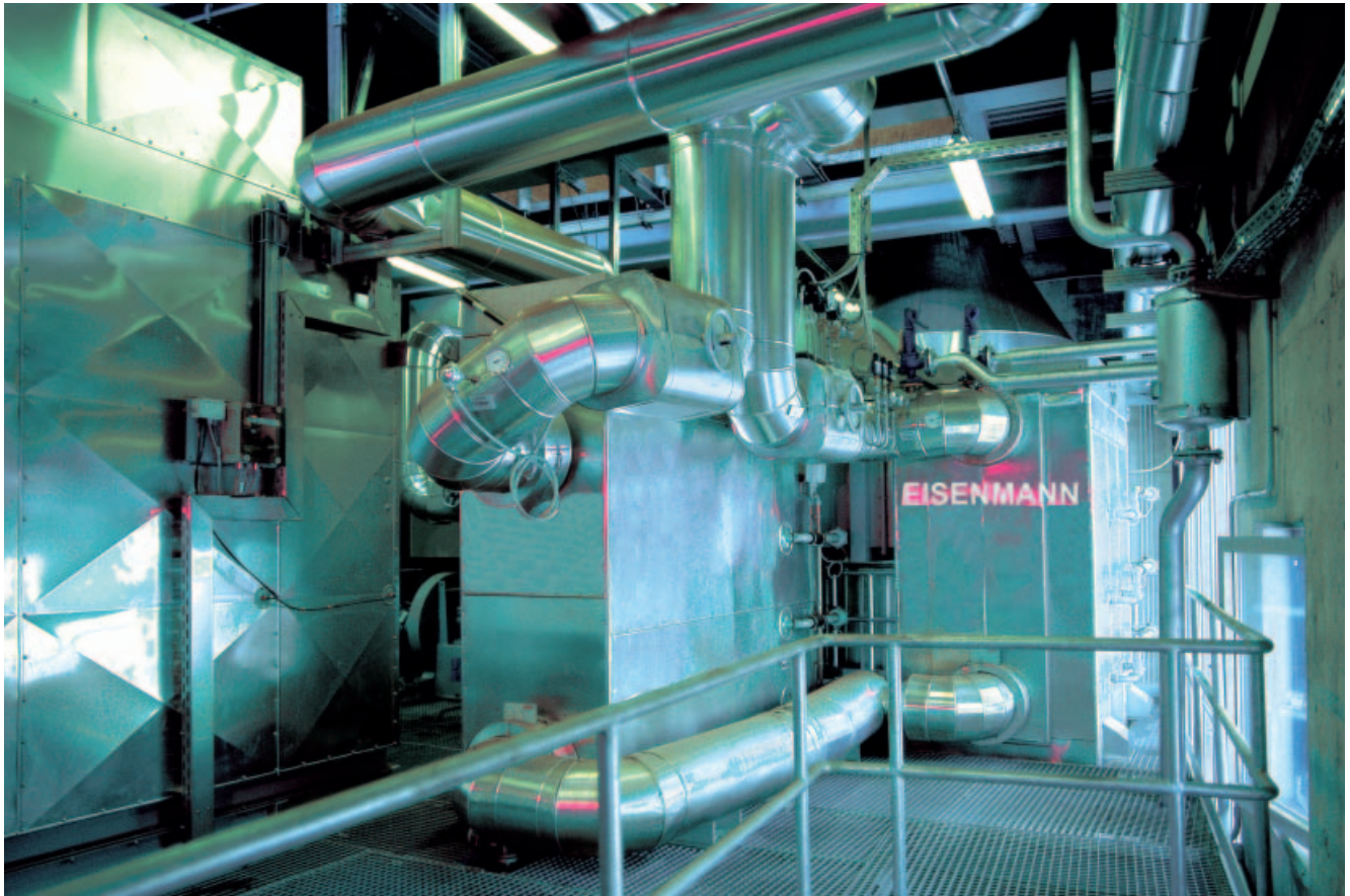
Fig. 3: Scambiatore di calore olio diatermico / acqua calda
