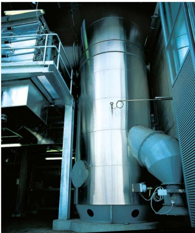
Abb. 2: Die nachgeschaltete Brennkammer zur Rauchgasreinigung
